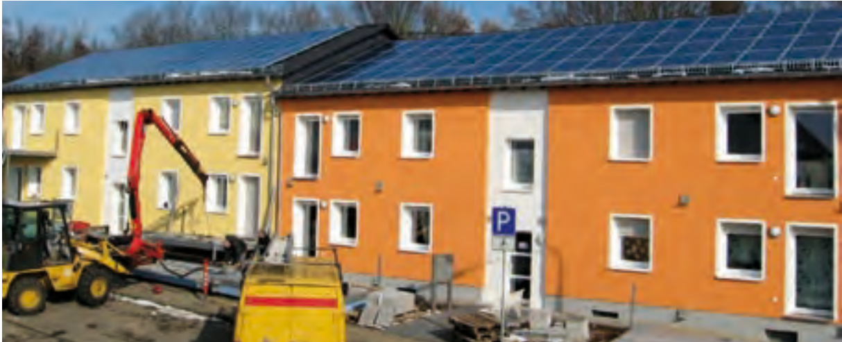
Energetische Sanierung eines Mehrfamilienhauses
