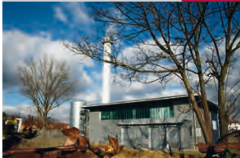
Holz hackschnitzel-Heizanlage im Quartier „Normand“ in Speyer
