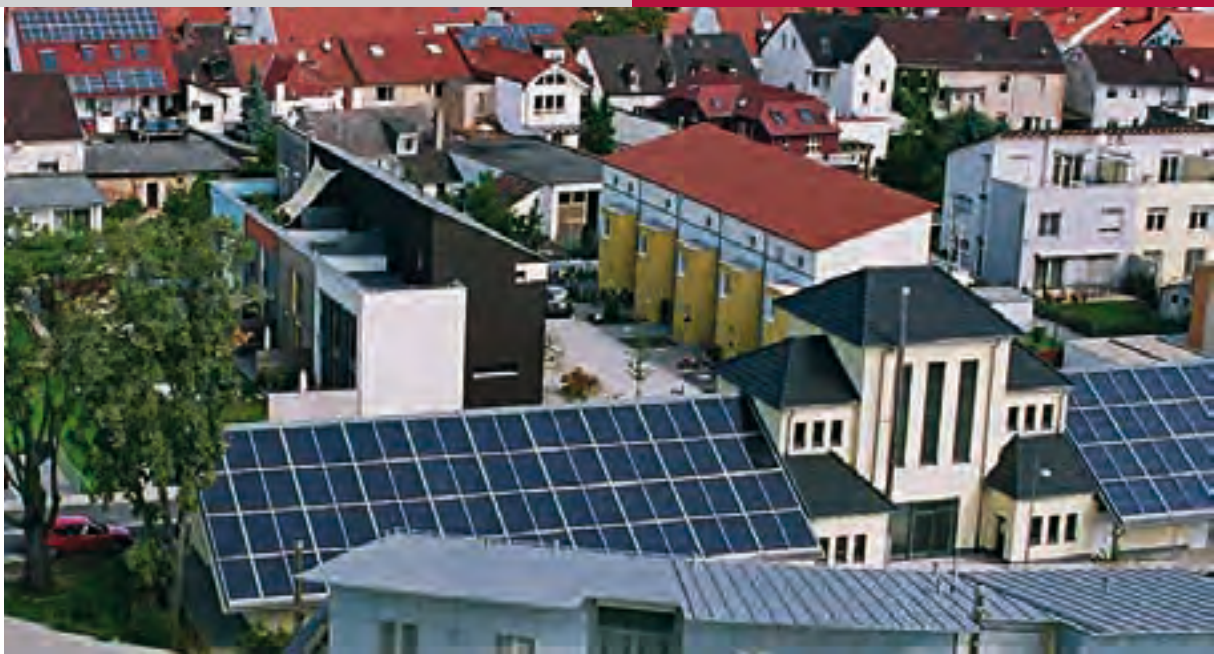
Beispiel Solarthermieranlage zur Warmwasserversorgung im Quartier
