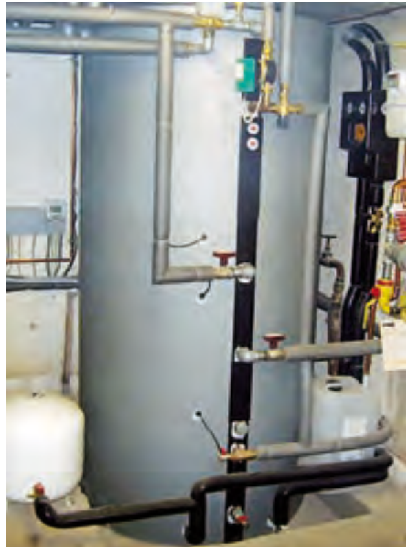
Austausch der alten Heizungsanlage
