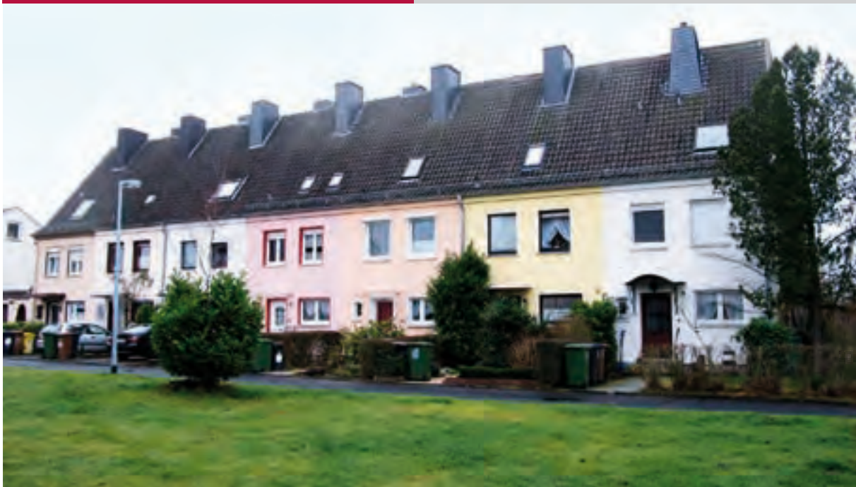
Grenzhausen: Sanierte Reihenhäuser
