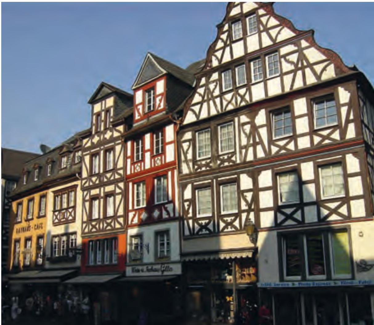
Sanierung von Fachwerkhäusern in Cochem
