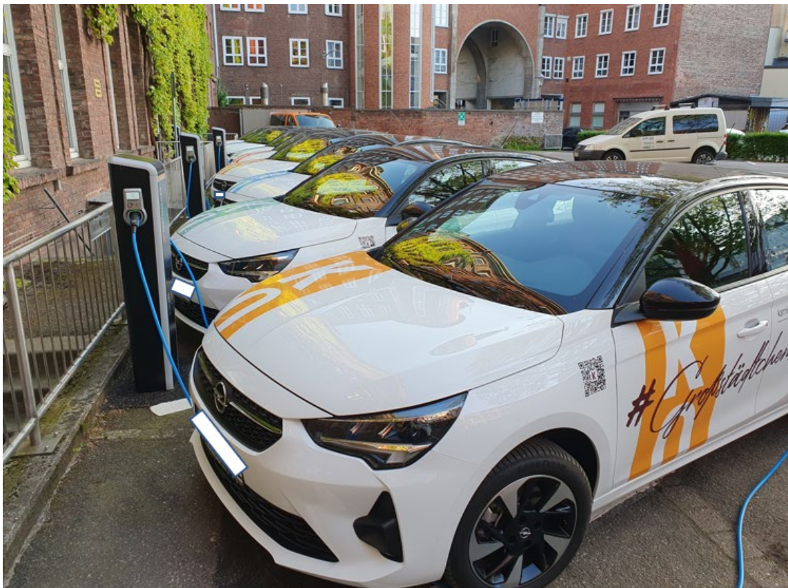
Abbildung 3: Ladesäulen für E-Fahrzeuge im Fuhrpark der Stadt Koblenz
