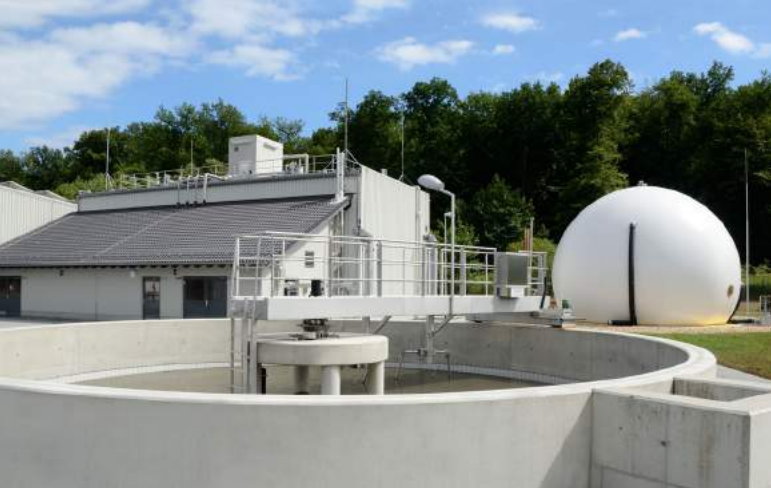
Abbildung 31: Vorkläranlage mit Gasbehälter und Faultrum
