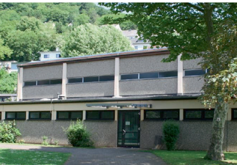
Abbildung 21: LED-Umrüstung Sporthalle Hasenkümpel
