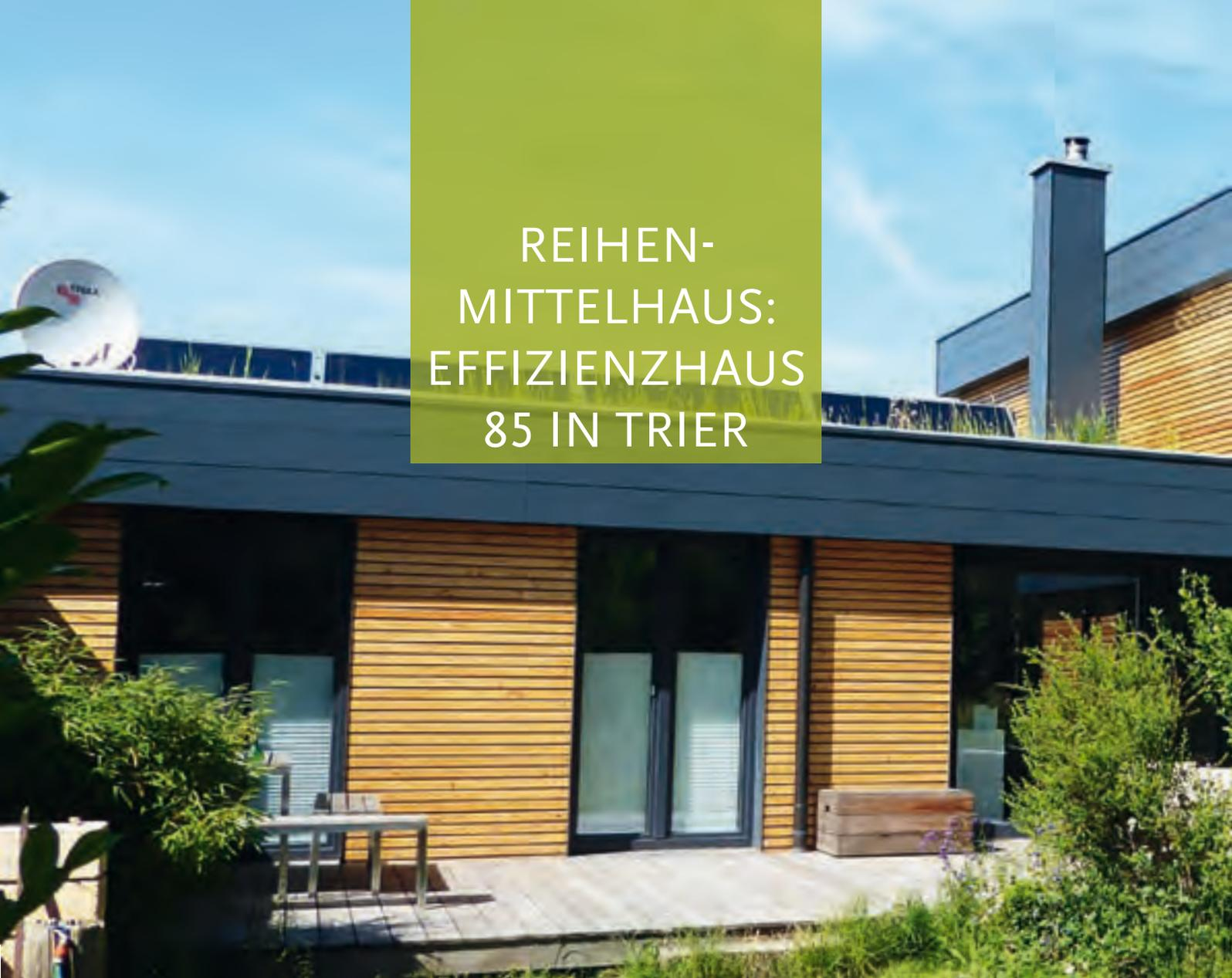
Das in Massivbauweise errichtete Reihenhaus befindet sich am Ende eines in den 60er-Jahren entstandenen Wohngebietes in Trier. Die 167 m<sup>2</sup> Wohnfläche erstrecken sich über das Erdgeschoss mit L-förmigem Grundriss und das kleinere Obergeschoss. Das Gebäude ist teilunterkellert.
