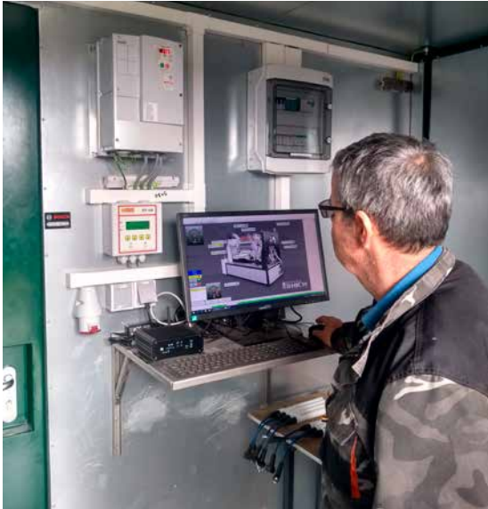
Abbildung 18: Geschäftsführer Manfred Lieser in der BHKW Leitwarte. © Energieagentur Rheinland-Pfalz
