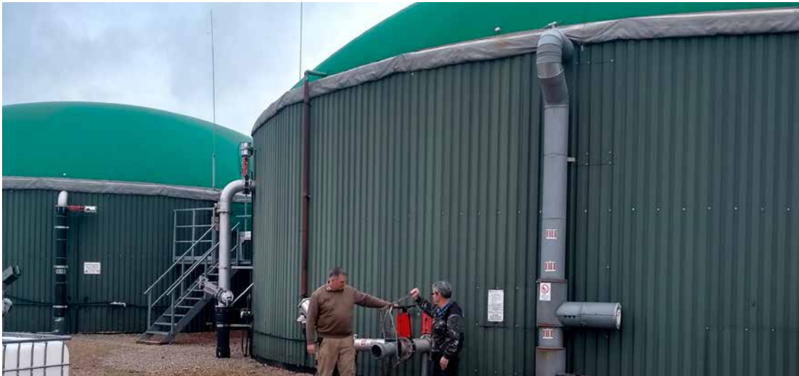
Abbildung 16: Blick auf die Biogasanlage Arenrath. © Energieagentur Rheinland-Pfalz
