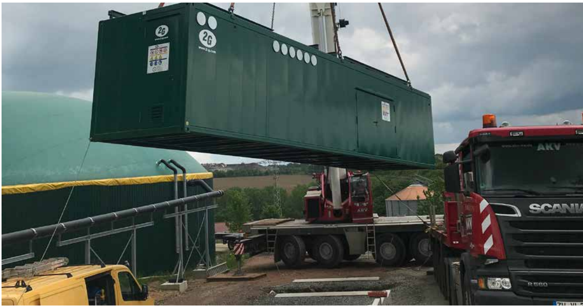
Abbildung 14: Aufstellung des neuen 1.500 kW BHKWs. © Energieagentur Rheinland-Pfalz
