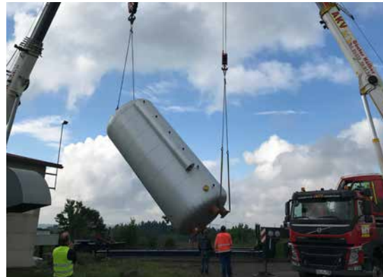
Abbildung 15: Anlieferung des Pufferspeichers.
