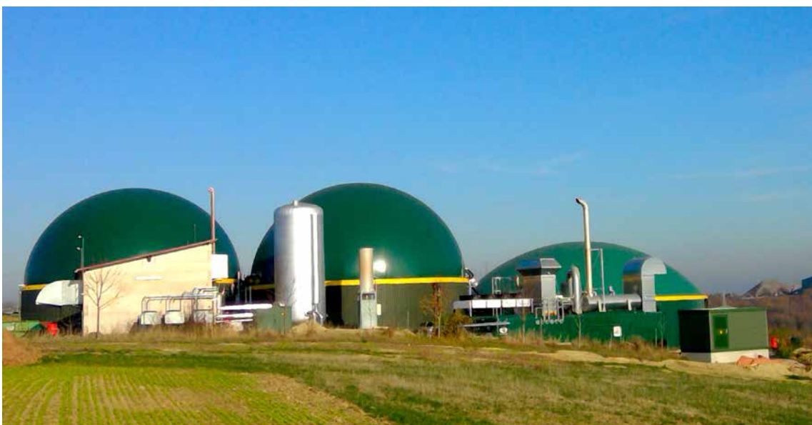
Abbildung 13: Blick auf die Biogasanlage Glahn Heilbachhof Zweibrücken. © ÖKOBIT
