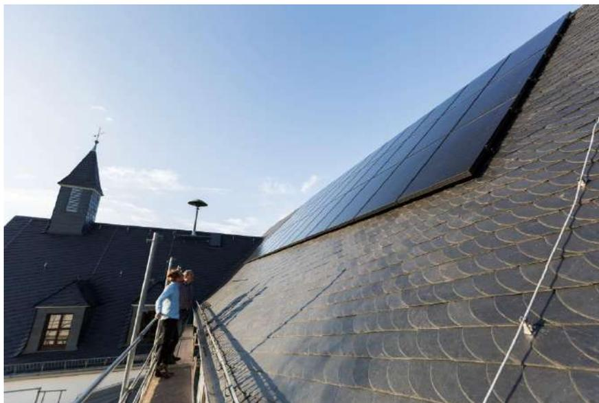
Anfang Mai 2017 wurde auf dem sanierten Gemeindehaus Photovoltaik-Anlage mit einem Batteriespeicher installiert. Die PV-Anlage ist in die Schieferdachdeckung gut integriert. Mit dem durch die Sonne gewonnenen Strom wird die LED-Straßenbeleuchtung im kompletten Ort betrieben.
