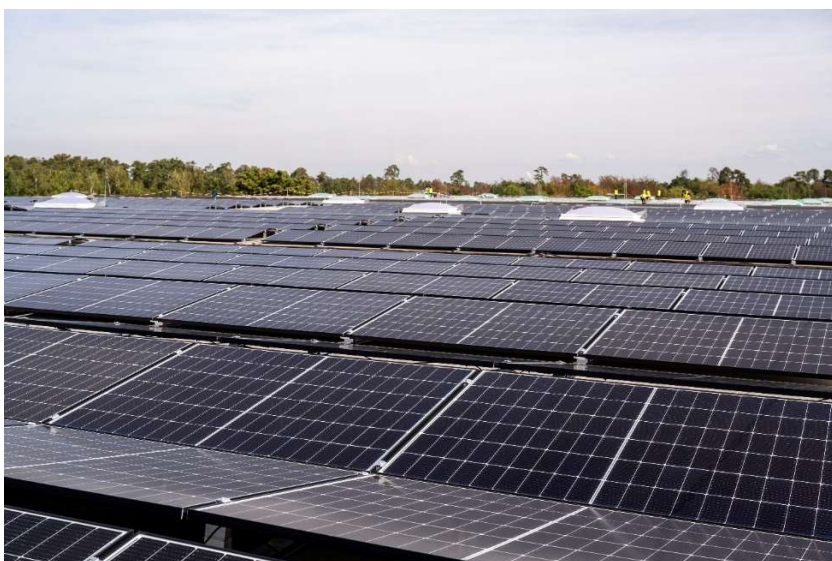
Die neue Photovoltaikanlage mit einer Gesamtleistung von 1.889 Kilowatt ist Teil der Regionalstrom-Plattform der SWS. Dort können Interessierte Energie aus Wind- und Solaranlagen aus der Region beliebig kombinieren oder den vorgeschlagenen Mix beziehen. Foto: Stadt Speyer
