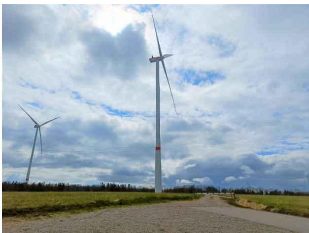
Zwei der Windräder im Windpark Kröppen I, Bild: Energieagentur Rheinland-Pfalz
