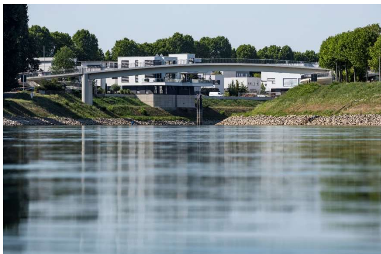
Ludwigshafener Bauprojekt: die Schneckennudelbrücke. Bild: Stadt Ludwigshafen / Martin Hartmann
