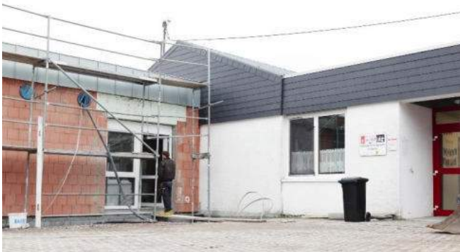
Foto/photo : Energieagentur Rheinland-Pfalz
