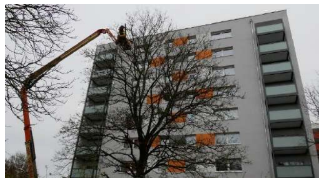
L'immeuble dans la Fasanenallee 4 juste avant sa finalisation (décembre 2020) (photo : ARGE SOLAR)
