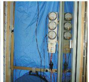
Foto / photo : ARGE SOLAR / Ralph Schmidt
