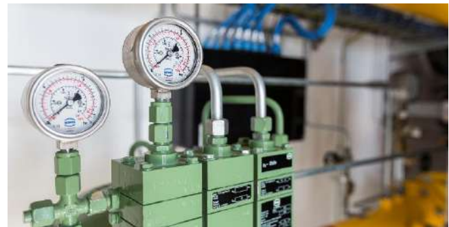
Foto / photo : Energieagentur Rheinland-Pfalz
