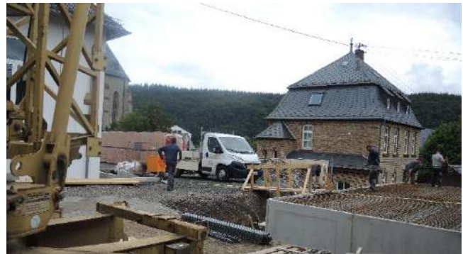
Foto / photo : Energieagentur Rheinland-Pfalz
