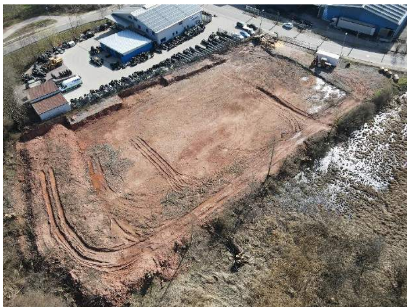
Abbildung 3: Das Baugelände des Forsthof Annweiler bei den Erdarbeiten (Foto: Trifels Natur GmbH)
