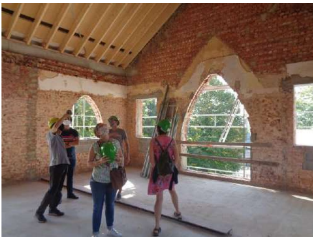
Citénergie Aubel, Foto/photo : ARGE SOLAR
