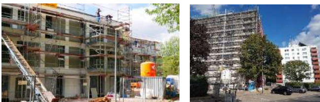
Neubau KfW 40 plus im Husarenweg (links) und Sanierung KfW 55 in der Fasanenallee (rechts) in Saarlouis am 26.08.2020. (Fotos: ARGE SOLAR)
