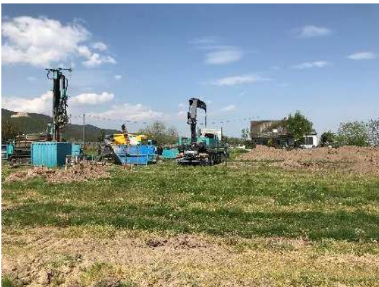
Herstellung der Pilotsonde (Foto: Pfalzwerke)
