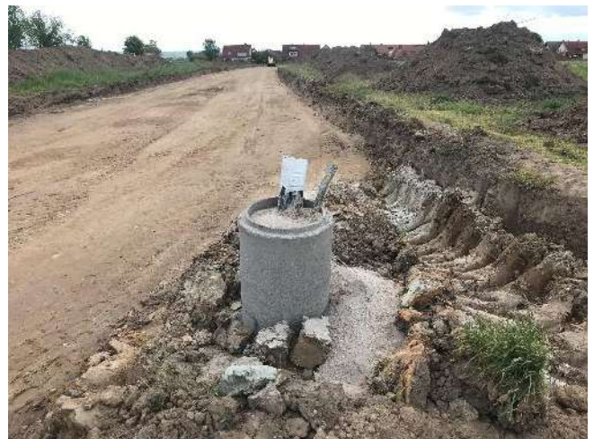
Forage pilote achevé – Celui-ci a lieu au début des travaux (Photo : Pfalzwerke)
