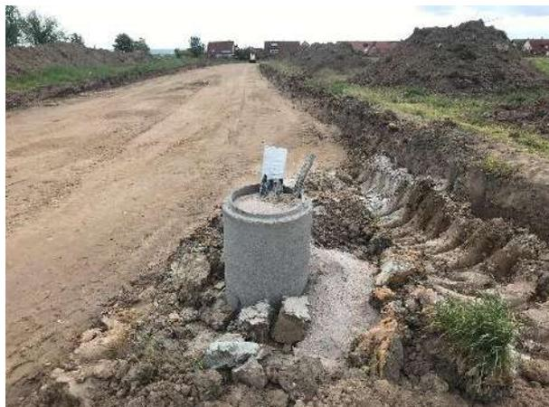
Fertiggestellte Pilotbohrung – Diese erfolgt früh im Bauablauf
