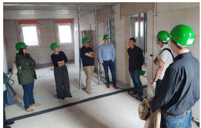
Architekt Ralf Heinrich erläutert Konzept und Ausführung des Pilotprojekts/ L'architecte Ralf Heinrich présente le concept et le déroulement du projet (Foto/photo: ARGE SOLAR)
