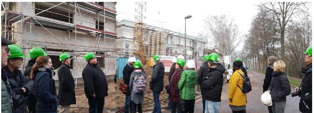
Baustellenbegehung am 12.12.2018 in Saarlouis Husarenweg 12/12a / Visite de chantier «Husarenweg 12/12a» le 12/12/2018 à Sarrelouis (Foto/Photo: ARGE SOLAR)
